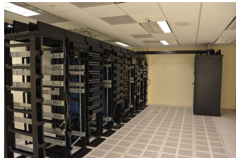
La “red eléctrica” del cómputo: enormes centros de datos.
